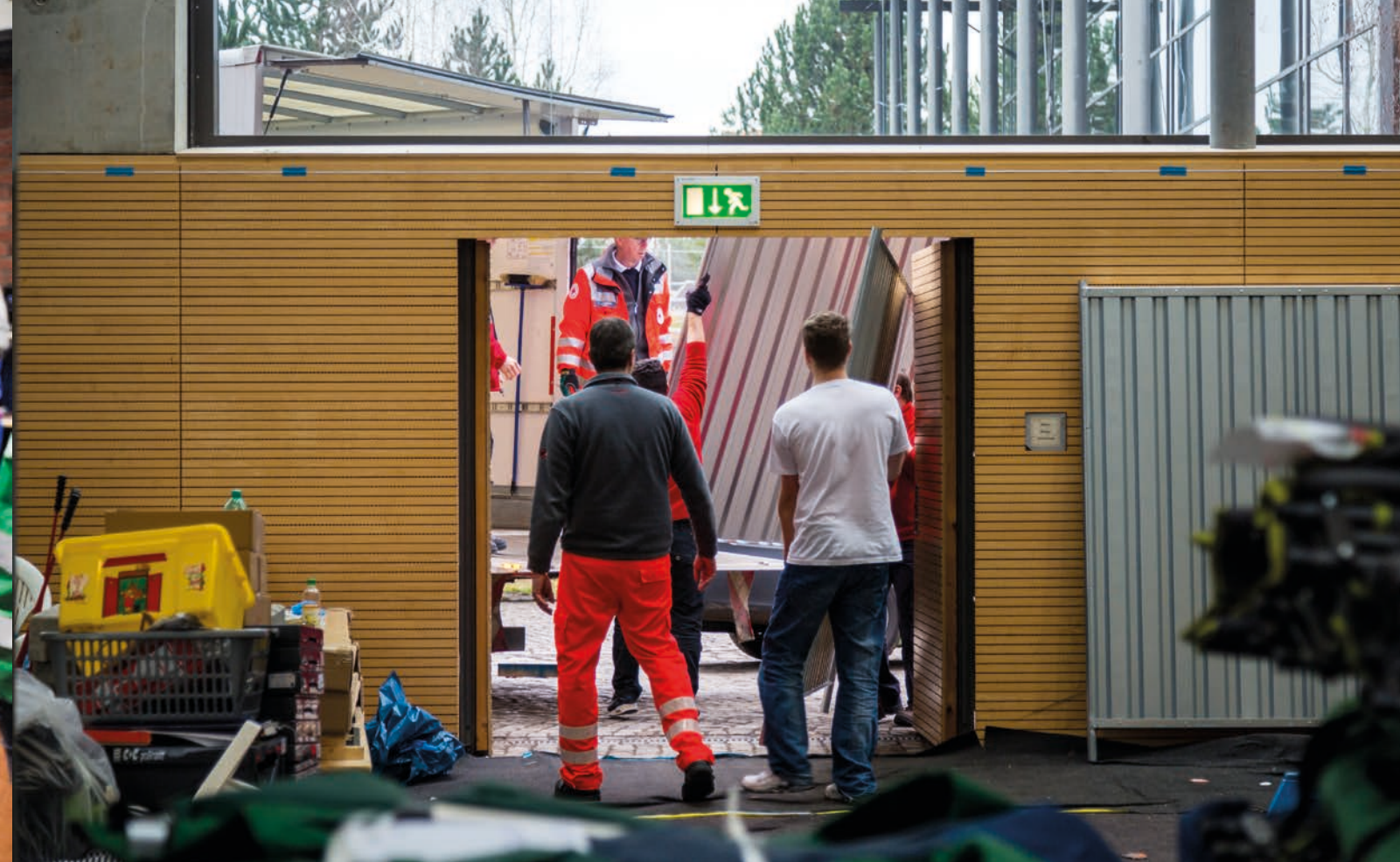
Abbau einer Erstaufnahmeeinrichtung (EAE) in Dresden
